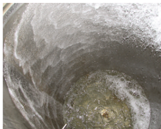
образование тонкой пленки на стенке деаэратора
