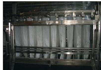
Рис. 5. Расположение фильтровальных мешков
